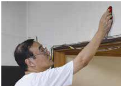
壁裏センサーを使って、壁の中にある下地材（木材や金属）を検知。
