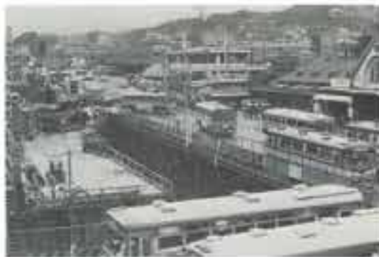
小田原駅東口地下街工事 1975(昭和50)年
